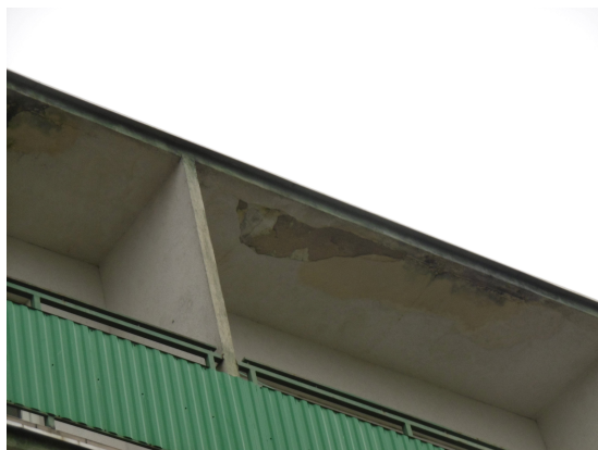
Fot. 6 Widok uszkodzeń daszków nad balkonami
