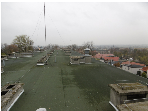
Fot. 3 Widok dachu
