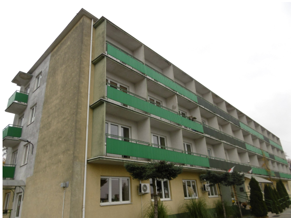
Fot. 1 Widok elewacji frontowej
